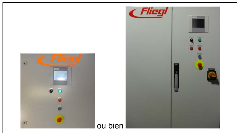
Fig. 3: Postes de travail sur la machine
